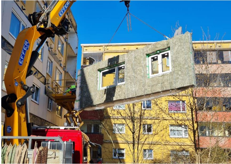
Paigaldatud fassaadielemendid ja lõplik fassaadi lahendus
