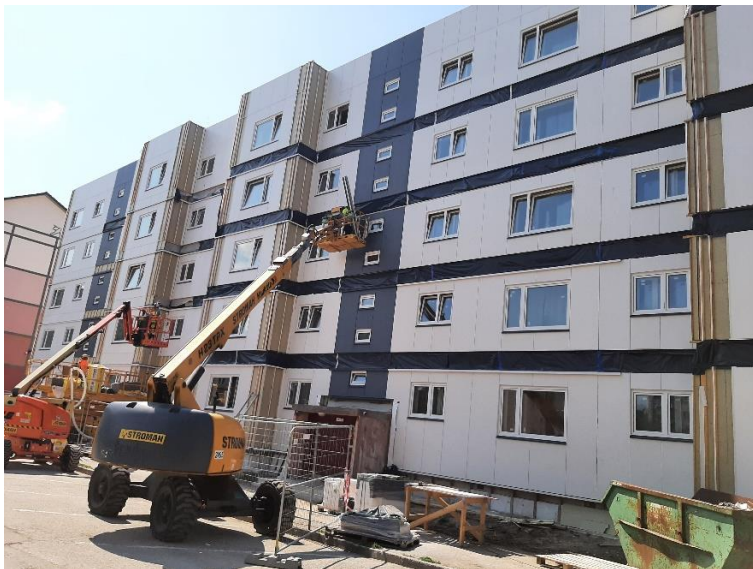
Paigaldatud fassaadielemendid ja lõplik fassaadi lahendus
