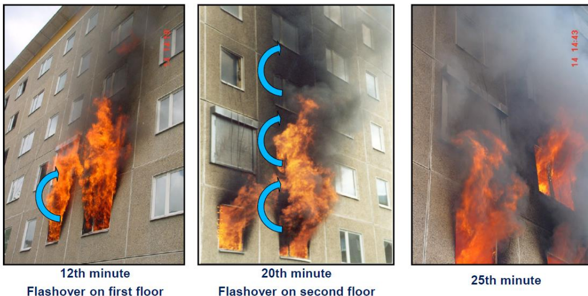
Joonis 22. Tule levik korruselt korrusele akende kaudu 14 .
