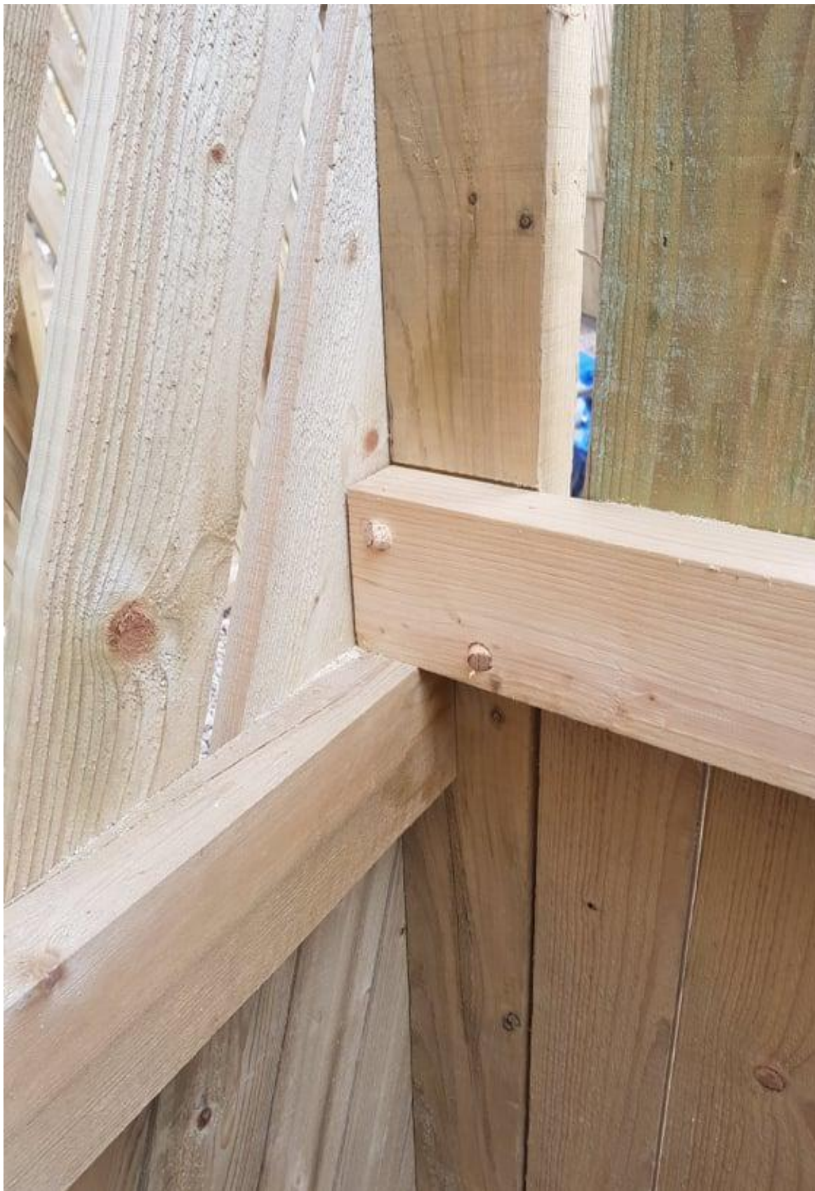
Joonis 6.1. Karkassiposti ja vööde liide.
