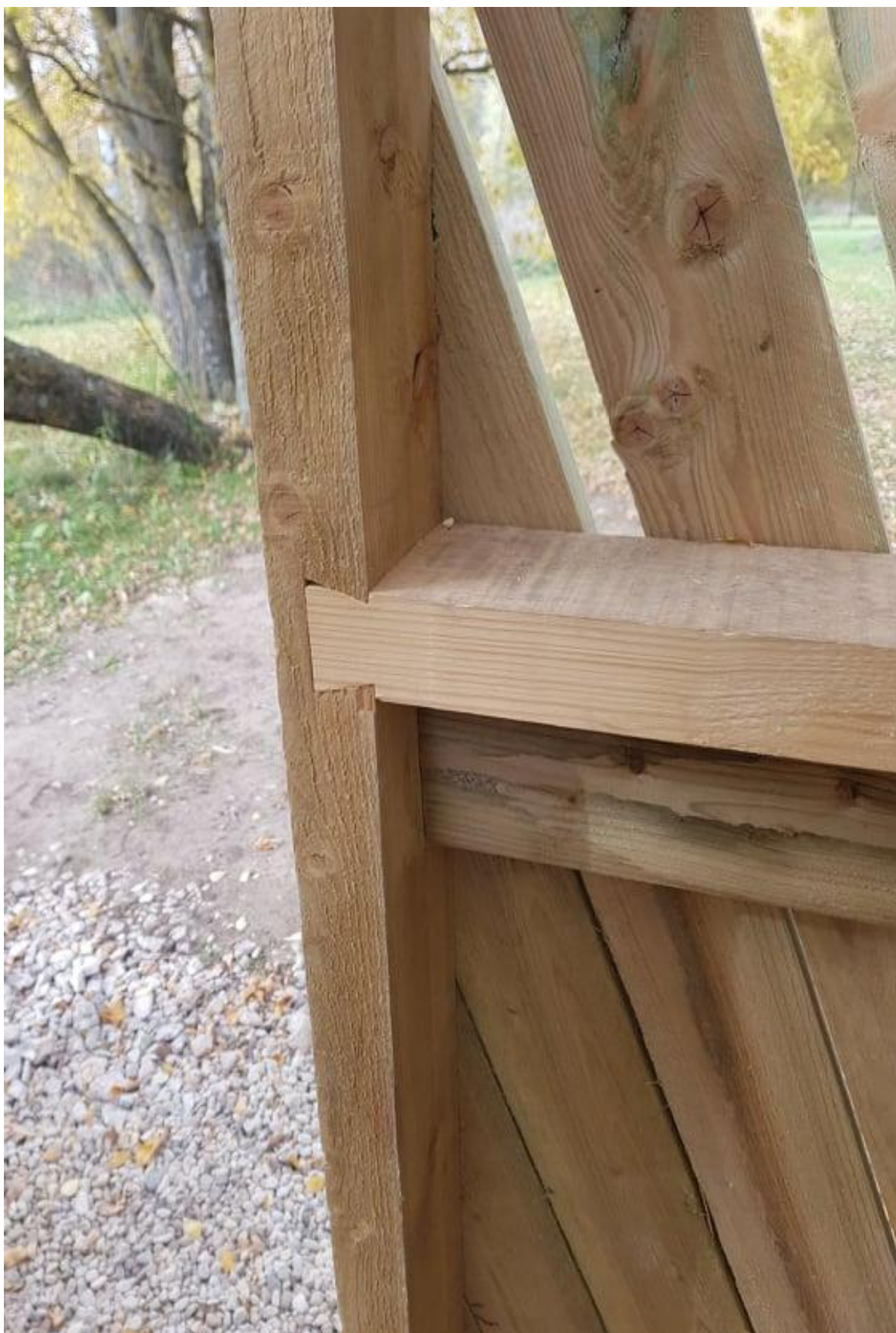
Joonis 6.2. Karkassiposti ja vöö kalasaba liide.
