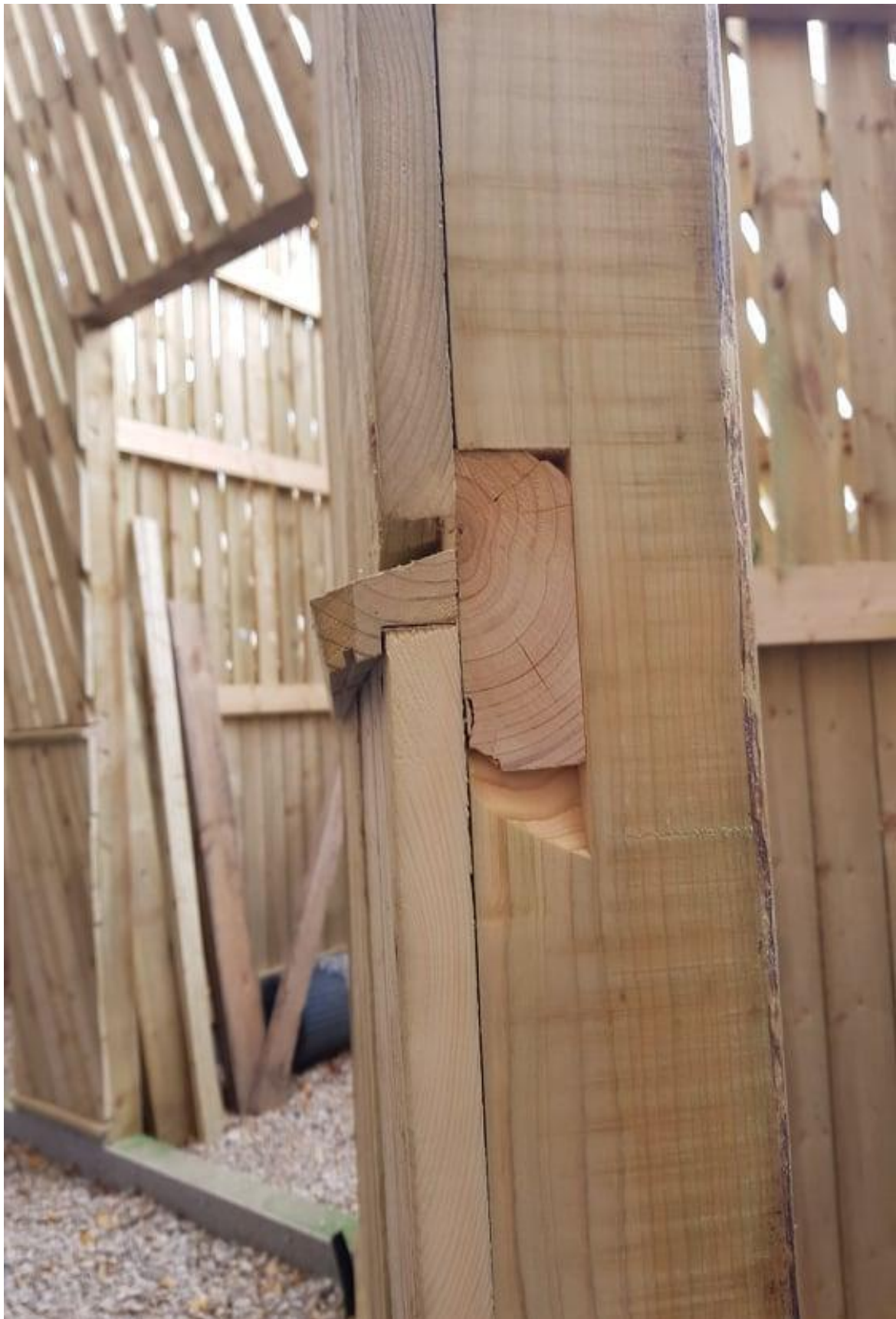
Joonis 6.9. Karkassiposti ja vöö kalasaba liide.
